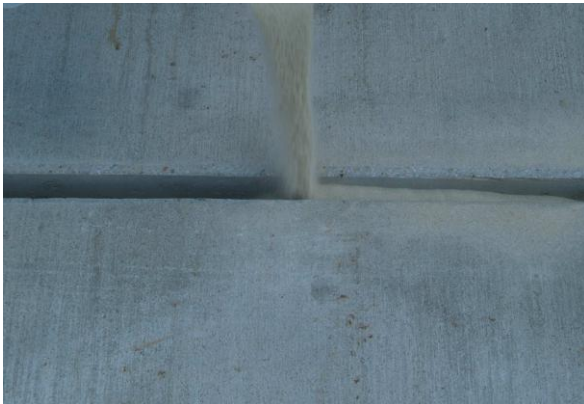
Запълнете част от фугата с пясък, за да запълните част от празния обем.
