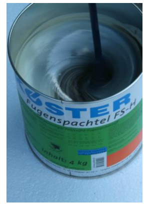
Разбъркайте добре двата компонента.
