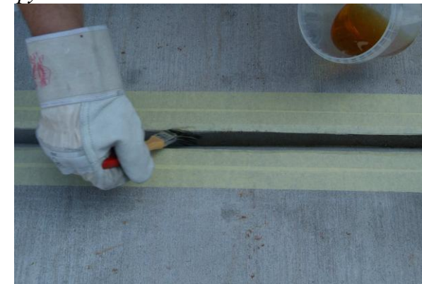
Намажете стените на фугата с FS-грунд.
